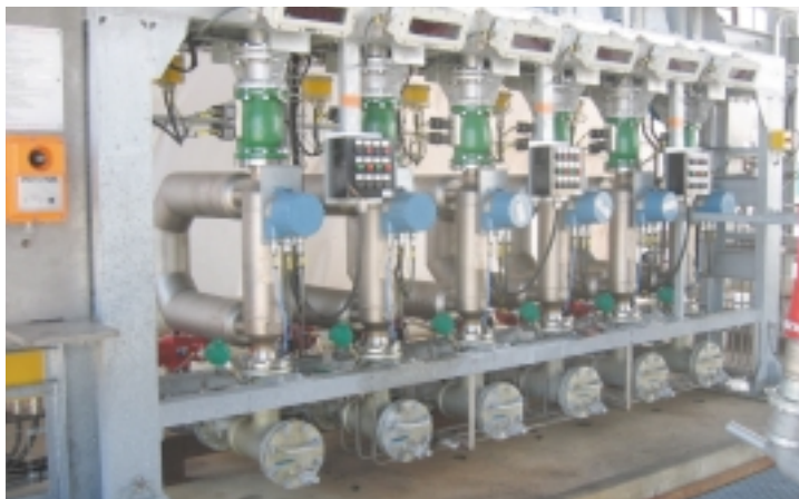
La directive MID va conduire à l'harmonisation du marché européen pour une dizaine de familles d'équipements de mesure entrant dans le champ de la métrologie légale. "Ici, ensembles de mesurage à compteur massique direct pour hydrocarbures liquides (MicroMotion)".
