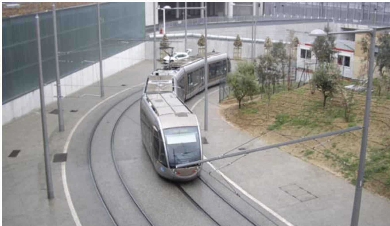
L'arrivée au terminus est entièrement gérée par des automates. L'aiguillage est complexe car il faut gérer le trafic des trains qui entrent et sortent du dépôt, de ceux qui repartent faire un trajet, et de ceux qui se dirigent vers la station de lavage ou vers l'atelier de maintenance.
