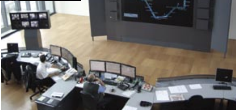
Les employés du PCC (poste de commande centralisé) assurent le contrôle du trafic bus et tramway, et surveillent tous les équipements et infrastructures techniques. Tous les postes sont équipés du progiciel de supervision Panorama E 2 de Codra.
